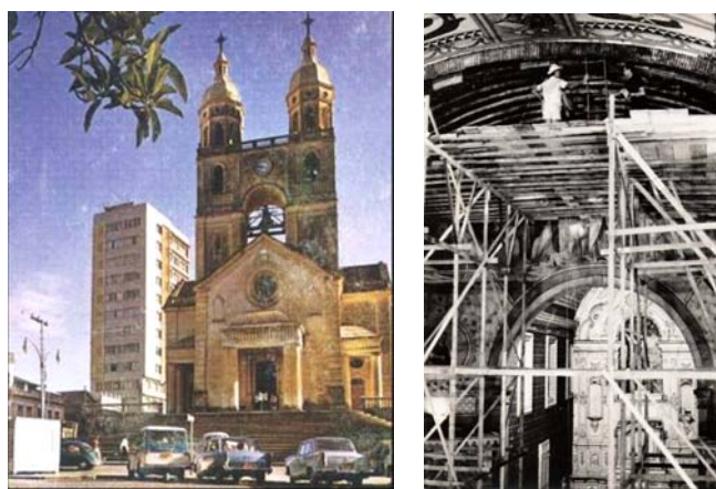
Figura 4 - Aspecto externo e interno da Catedral durante a reforma de 1974. Fonte: Acervo Prosul, 2005 e Acervo do Pe. Pedro José Koehler-1974
