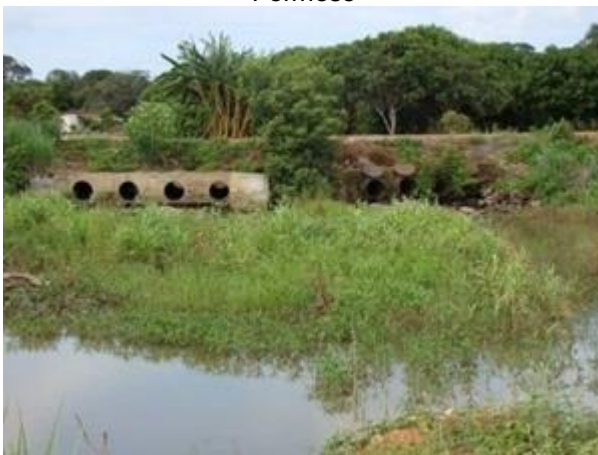
Figura 1.26: Descarga da Estação de Bombeamento de Irrigação EBI V na Adutora Formoso
