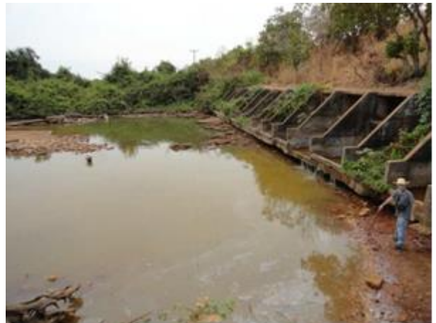
Figura 1.9: Dissipador de energia da tomada de água
