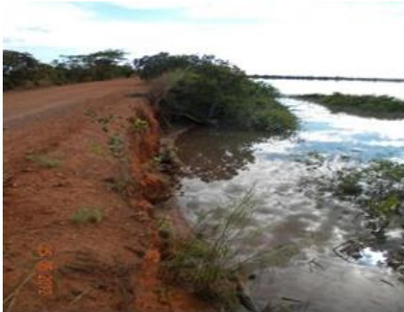
Figura 1.11: Talude de montante do eixo norte/sul da Barragem Calumbi I
