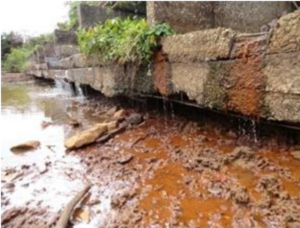
Figura 1.8: Detalhe da situação do dissipado
