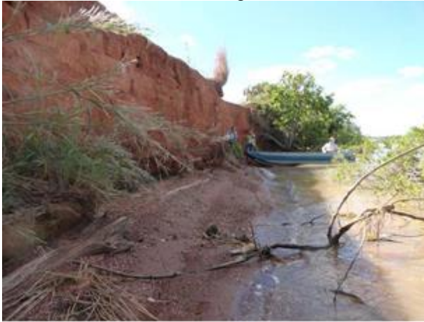
Figura 1.16: Talude de montante do eixo leste/oeste da Barragem Calumbi II
