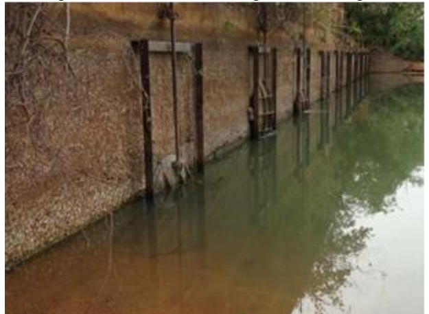
Figura 1.19: Tomada de água da barragem
