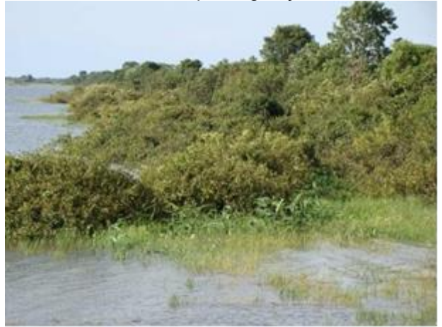
Figura 1.17: Talude do eixo norte/sul da barragem tomado por vegetação
