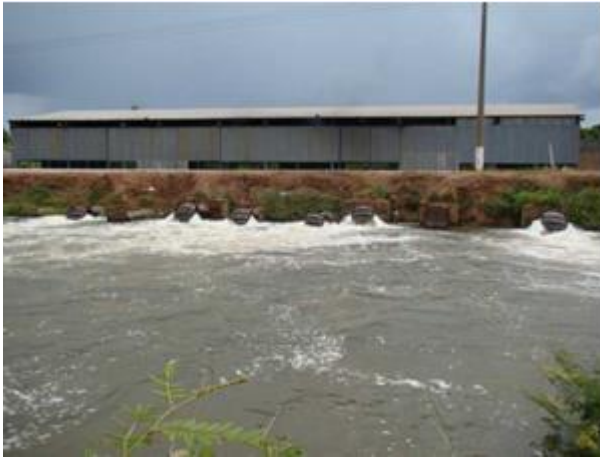
Figura 1.28: Vista externa e tubulação de descarga
