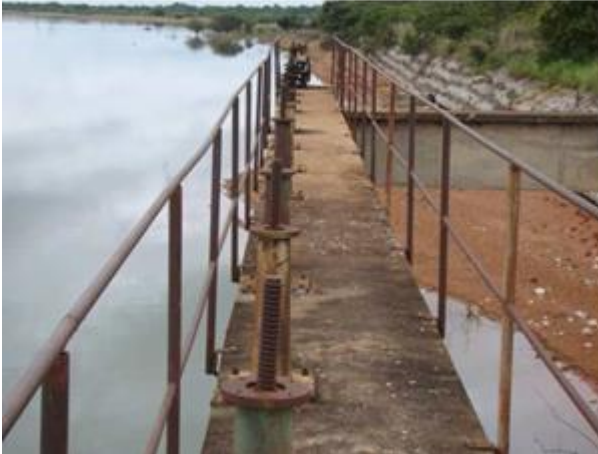
Figura 1.6: Tomada de água da barragem Taboca
