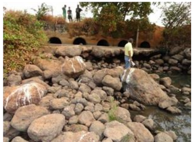
Figura 1.14: Dissipador de energia da tomada de água da Barragem Calumbi I no início da Adutora Rodoarte
